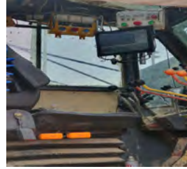
운전석 모니터 설치
